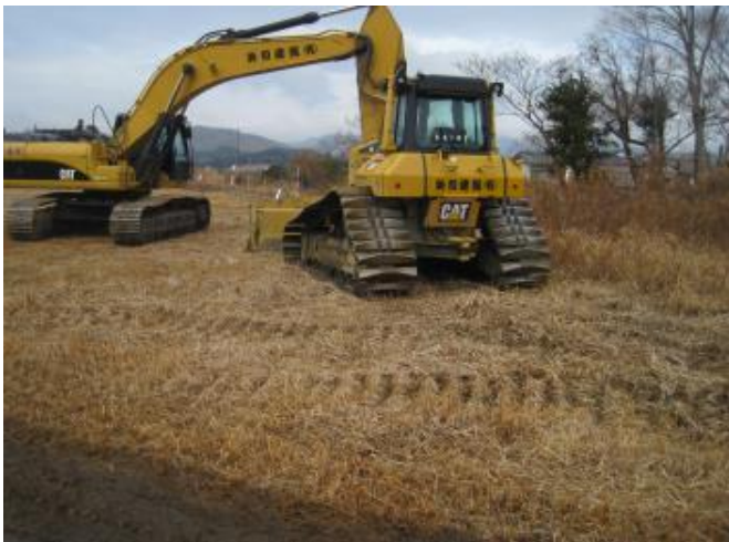
整地の重機搬入
