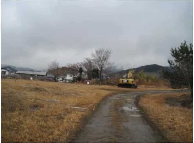
整地の重機搬入
